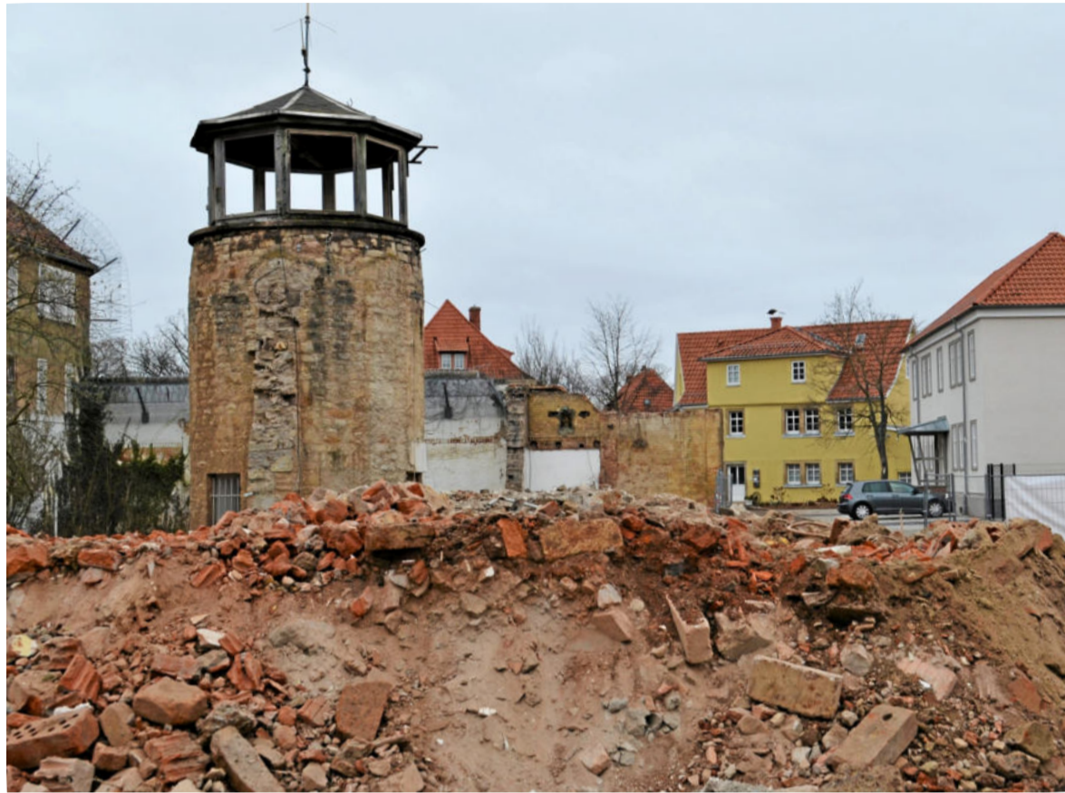
Die Hallen, die als Werkstätten für die jugendlichen Strafgefangenen der JVA genutzt wurden, sind abgerissen. Der Wachturm steht nun frei. Im Hintergrund sind Tor- und Freigängerhaus zu sehen. FOTO: MARIA HOCHBERG
