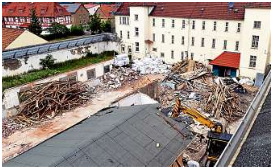
Vom Dach eines ehemaligen Hafthauses der Jugendstrafanstalt kann man sehen, dass der Abriss der Nebengebäude schon begonnen hat. Foto: Hans-Peter Stadermann
