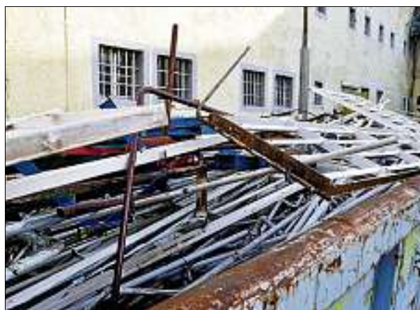
Jede Menge Schrott fällt gerade an. Türen und Fenstergitter werden entfernt und zum Schrotthändler gefahren.
